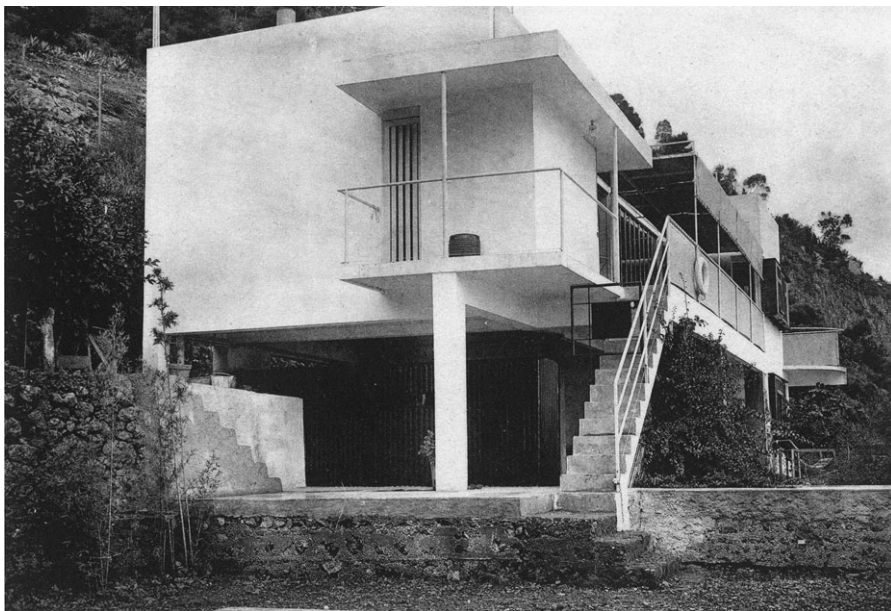
Fig. 8. E.1027 relación entre plantas y terraza cubierta « sous les pilotis ». (foto publicada en L'Architecture Vivant , 1929)
